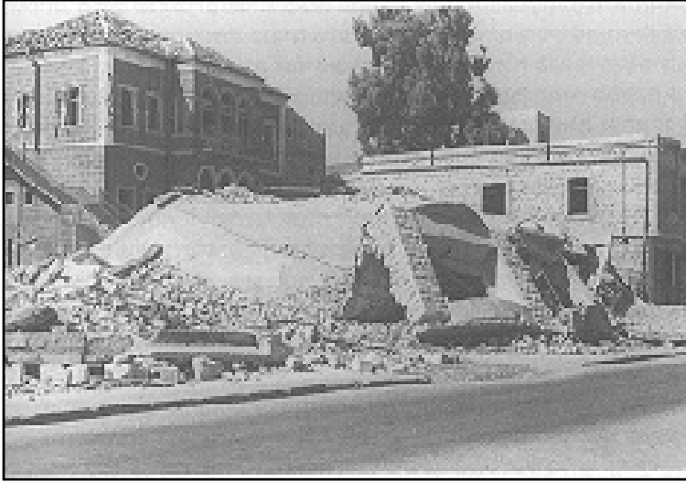
مبنى سكني ومكاتب في ساحة مدرسة الفرير (ساحة الهاغاناه اليوم)، هدمت أثناء وبعد معركة ستوط حيفا
